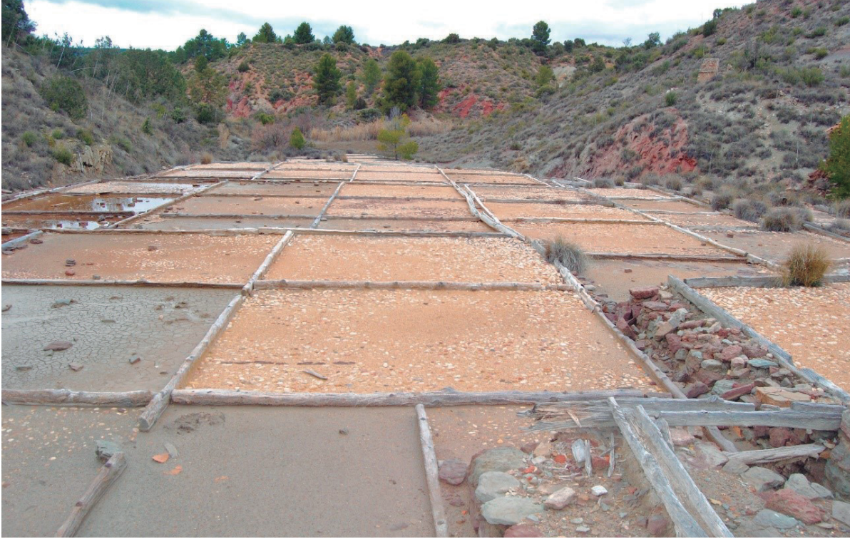
Figura 06. Detalle de las eras de cristalización y canales de conducción de la salmuera de las salinas de Villargordo del Cabriel. Elaboración propia (2021)
