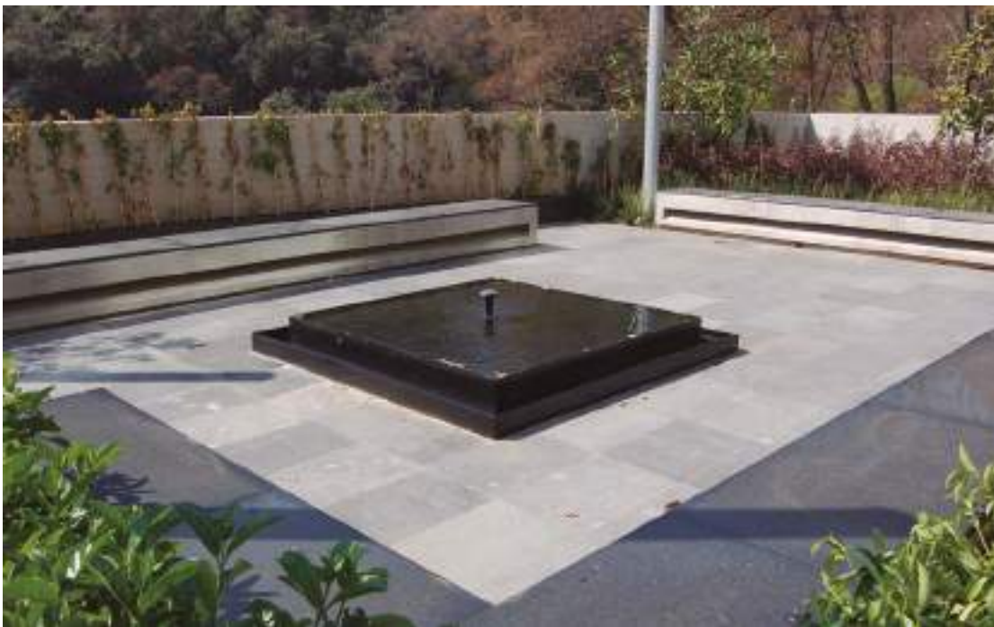
Fuente prefabricada de acero sobre estructura de estacionamiento, plaza conjunto La Cañada, Santa Fe, Ciudad de México
