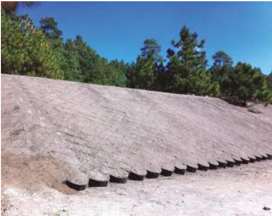
Uso de geoceldas para contención de talud
