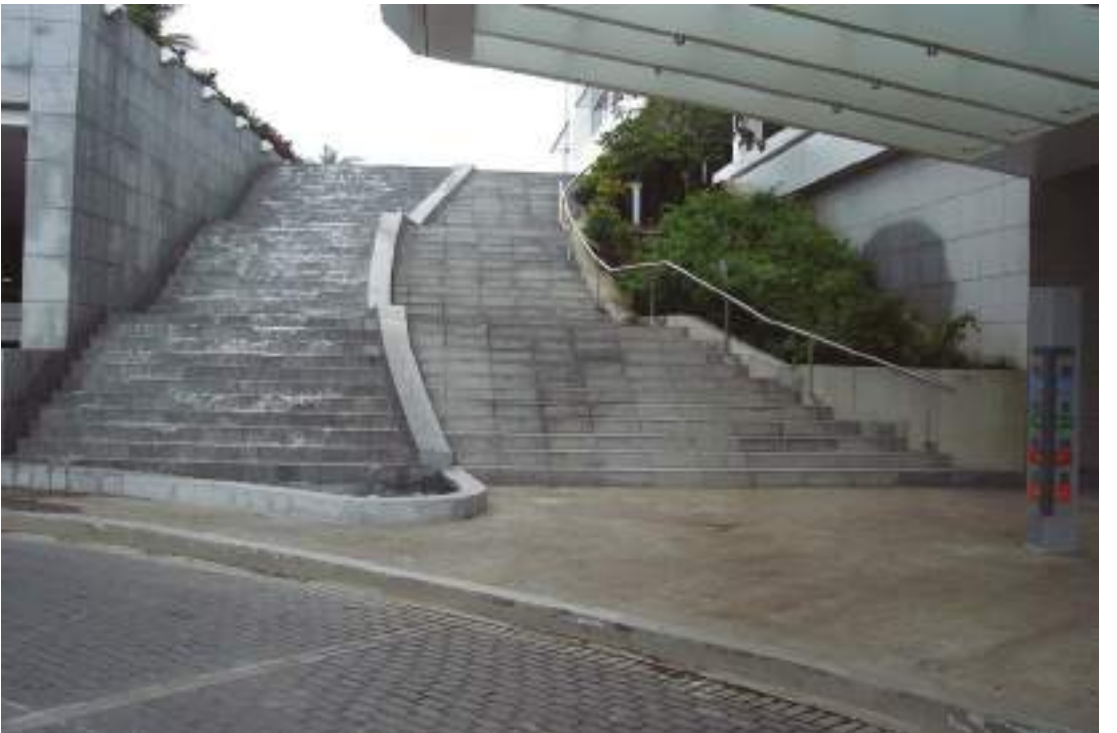
Detalles de escaleras, Bussines Park, Costa del Este, Panamá
