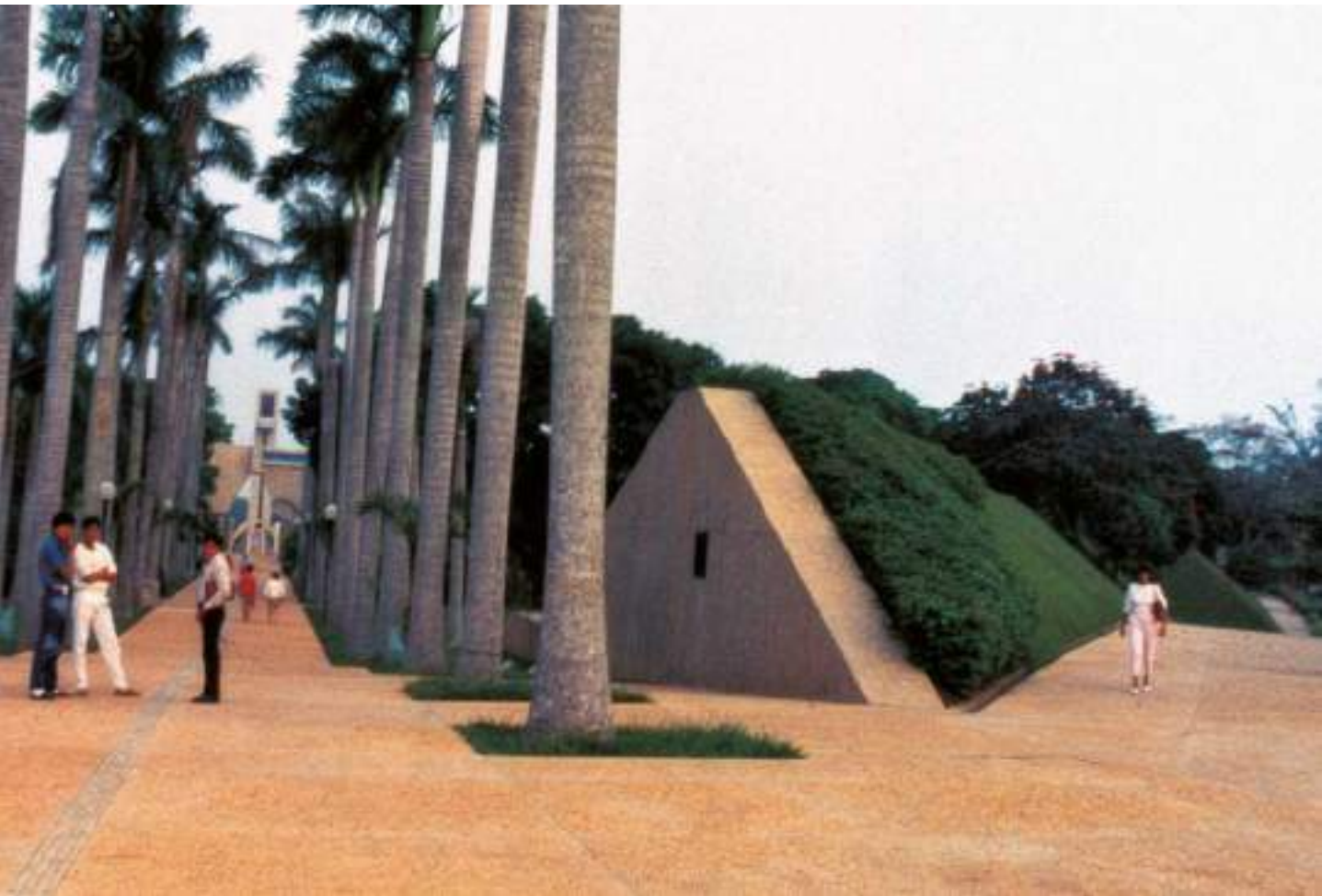
Taludes perimetrales como barrera acústica y visual, Parque Tomás Garrido, Villahermosa, Tabasco
