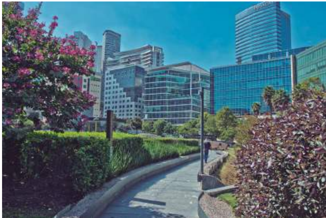
Jardín sobre estructura, centro comercial Garden Santa Fe, Ciudad de México
