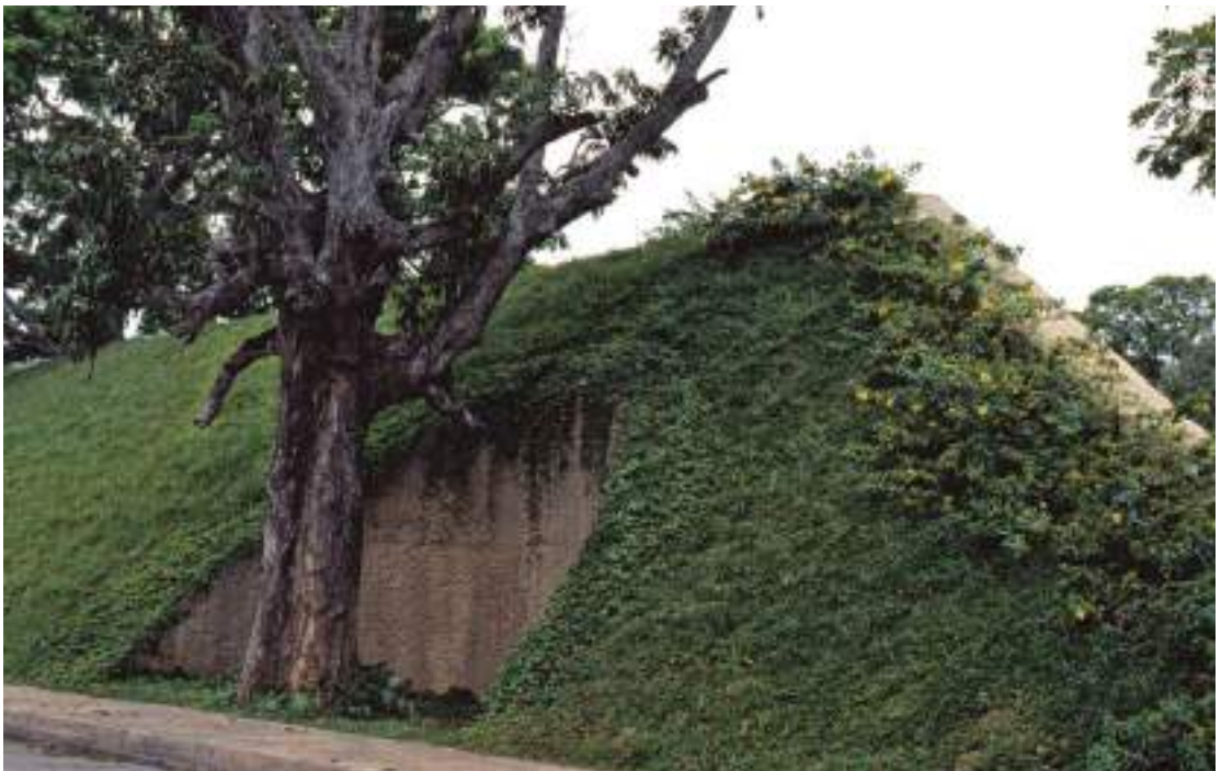
Protección de árboles mediante arriate en talud
