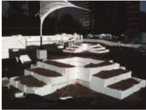
Criterio de relleno en losa para plantación de árboles
