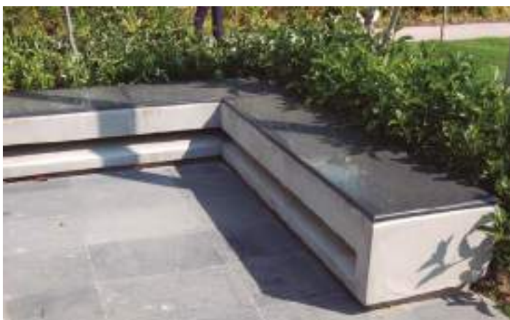
Detalle banca de concreto aparente con iluminación en la base y cubierta de granito
