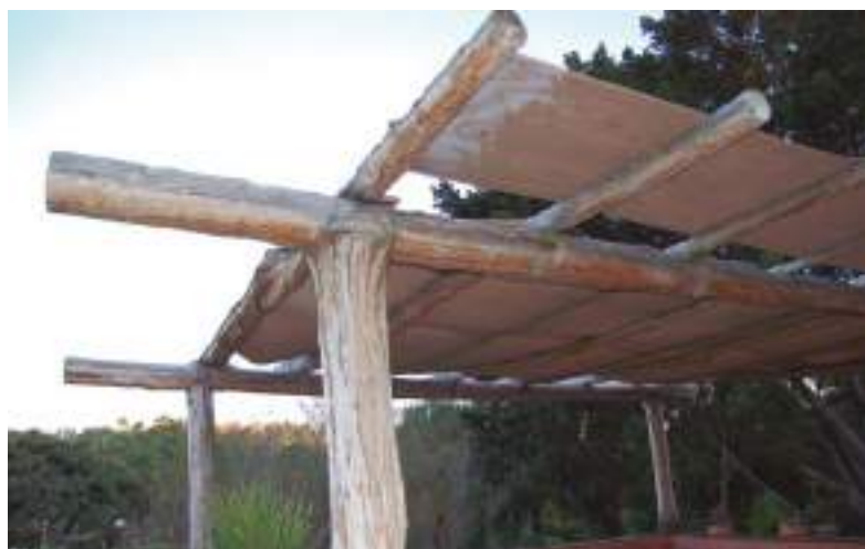
Detalles de pérgola rústica fabricada con troncos y una malla
