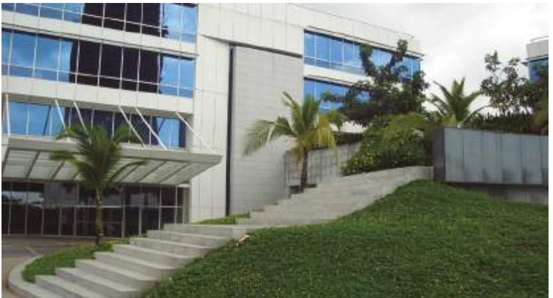
Detalles de escaleras, Bussines Park, Costa del Este, Panamá
